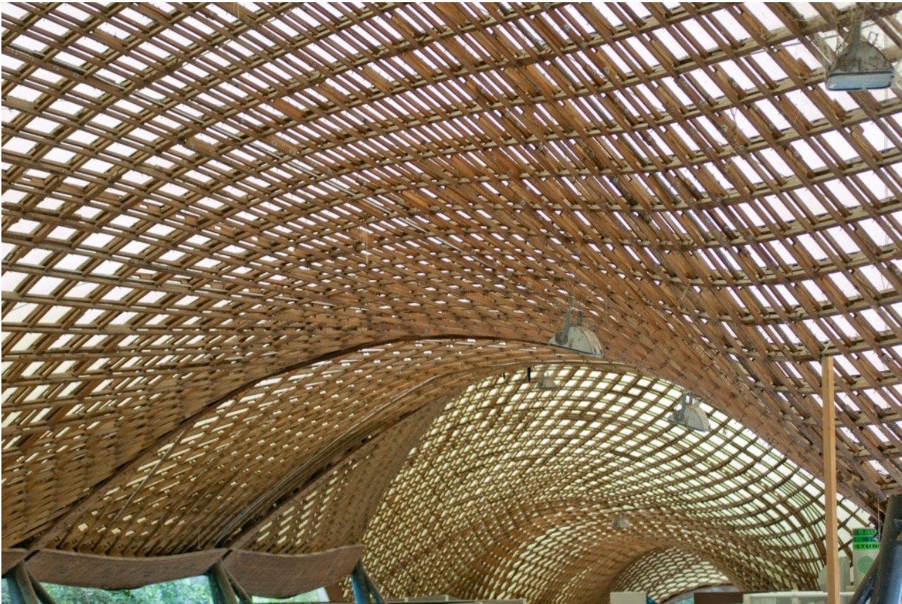
Frei Otto: Mannheim Multihalle
