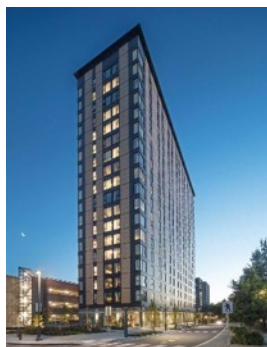
Brock Commons 2017 Vancouver, Canada 57.9 m / 18 Fl
